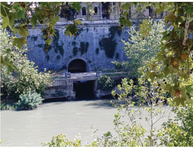
Fig. 5 - Veduta dello sbocco al Tevere della Cloaca Maxima sulla sponda sinistra, al di sotto di Lungotevere Palatino.
