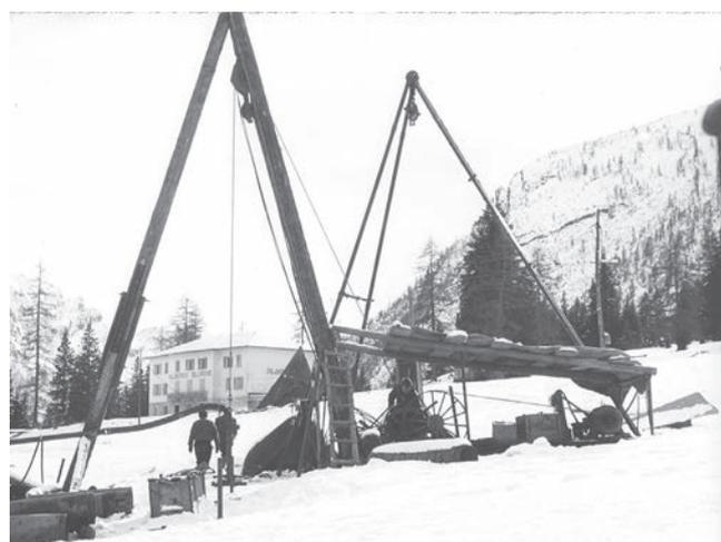
Fig. 6 - Sondaggi eseguiti a percussione nei terreni con tubazioni di rivestimento di diametro 300-400 mm; manovre con argani a fune metallica (Rodio - Località Gaver, 1960).
