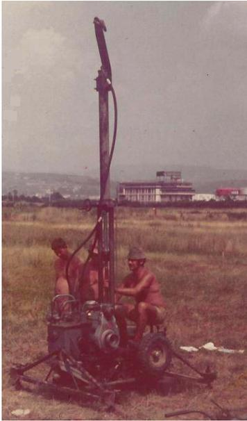
Fig. 9 - Il penetrometri statico Gouda da 10 t (Studio Celotti- Milano, 1965).
