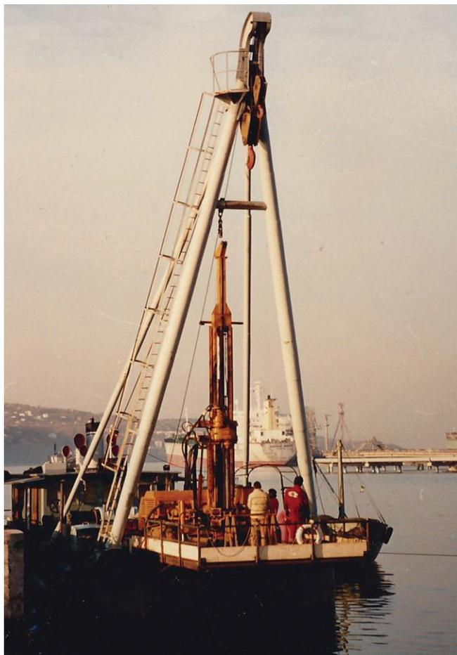
Fig. 19 - Sondaggio da pontone galleggiante in acque calme (Porto di Trieste – Impresa Imprefond, 1975).
