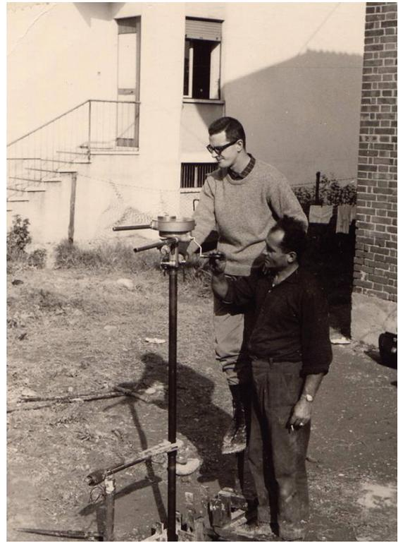
Fig. 11 - Il "Vane Borer" Geonor utilizzato in cantiere (Rodio, Reggio Emilia, 1963).
