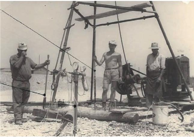
Fig. 1 - I primi pressimetri Menard (Rodio - cantiere Ostiglia), 1960.
