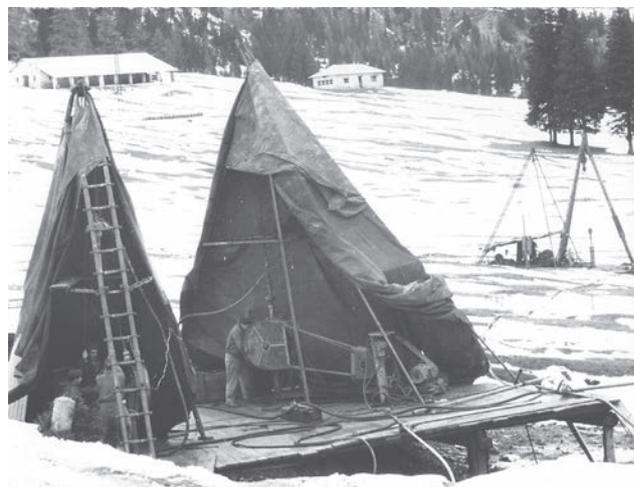
Fig. 7 - Sondaggi eseguiti a percussione nei terreni con tubazioni di rivestimento di diametro 75 - 150 mm; manovre con cabestano e fune di canapa (Rodio - Località Gaver, 1960).
