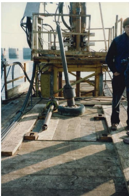
Fig. 13 - Il dispositivo di battitura per prove SPT con sganciamento automatico del maglio (Costruzione Nenzi, 1967).
