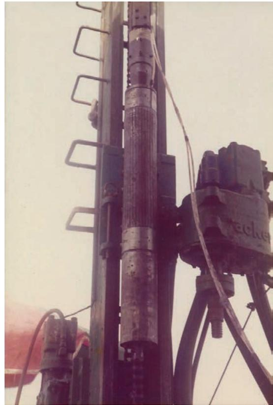
Fig. 22 - Il pressimetro autopercorante francese Pafsor; Impresa Rodio (cantiere: Iran, Bandar Abbas), 1978.
