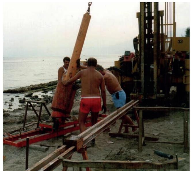
Fig. 23 - L'attrezzatura "Large SPT" per le prove nei terreni ghiaiosi (Stretto di Messina - Impresa Radaelli e Castellotti, 1985).
