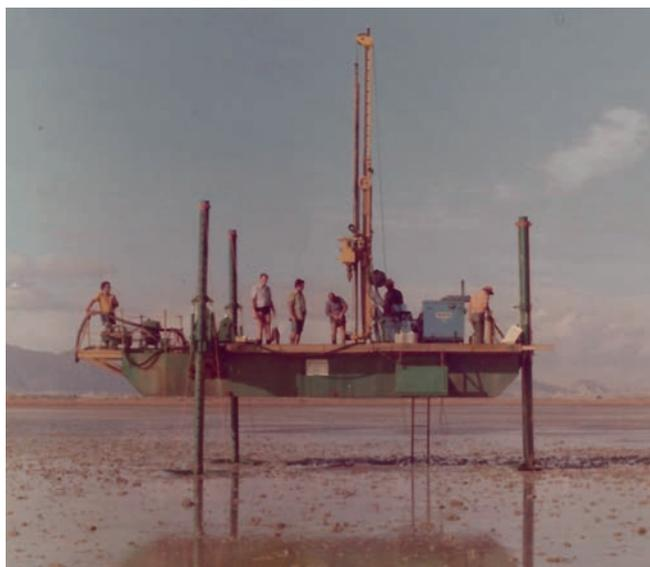
Fig. 20 - Sondaggio da piattaforma autosollevante (Iran – Porto di Bandar Abbas, 1976).
