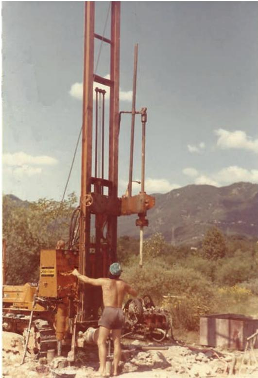
Fig. 16 - Le prime perforatrici a testa idraulica utilizzate in Italia (Atlas Copco - AB 30÷50; Impresa Radaelli e Castellotti, 1968).
